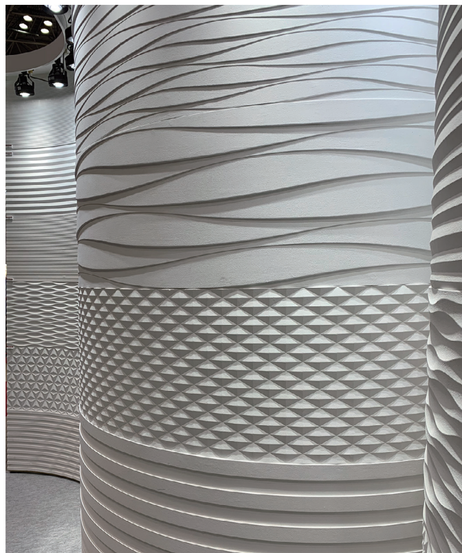
内・外 800R ウェット工法にて施工
